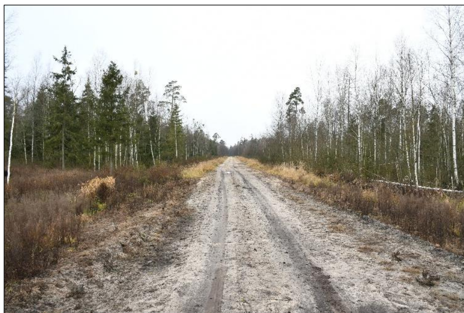
Рисунок 2.3 – Грунтовая лесная дорога
